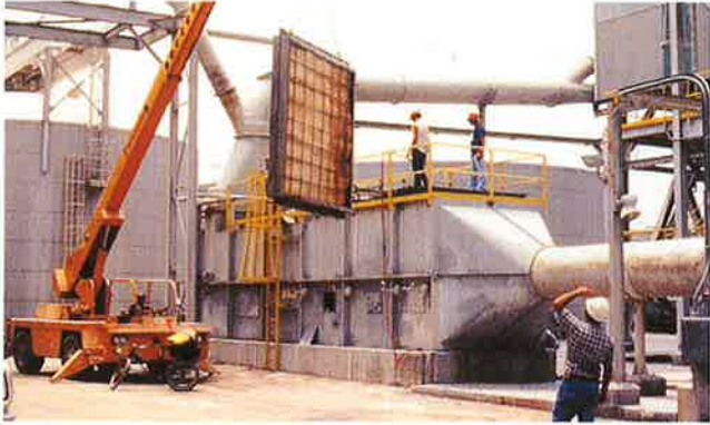
▲過リン酸石灰スクラバー (2,000m 2 /min)
